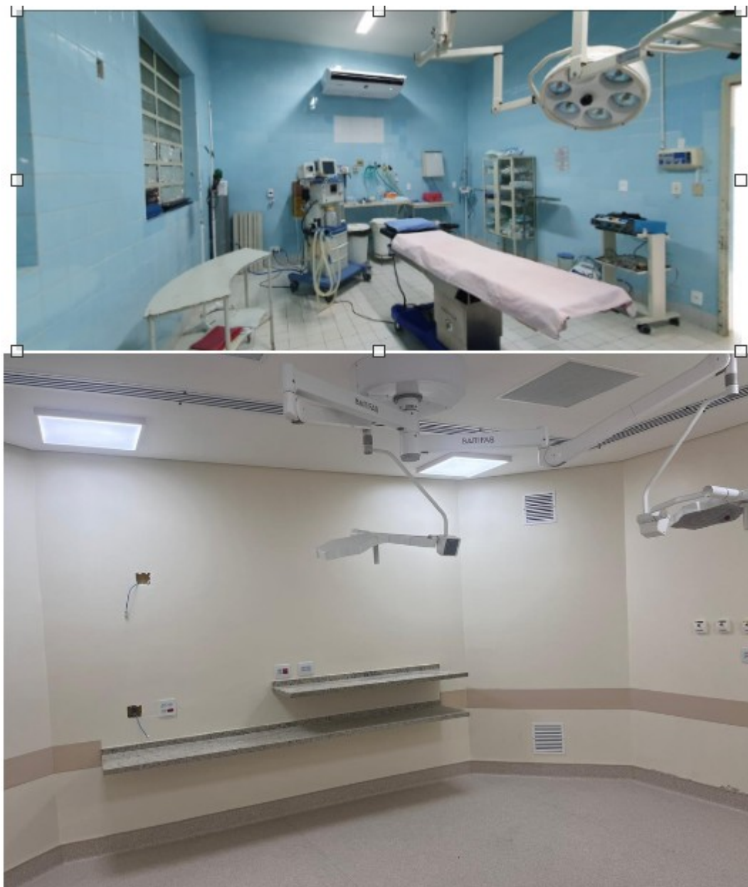
Figura 8: Sala de Cirurgia 1, antes e depois da reforma
