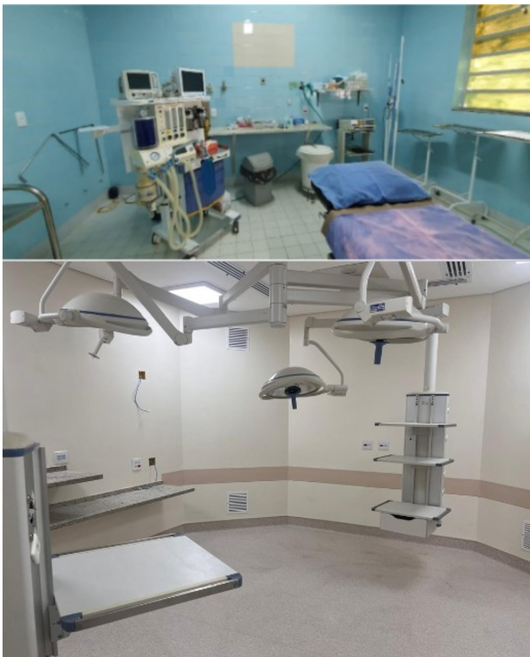
Figura 9: Sala de Cirurgia 2, antes e depois da reforma
