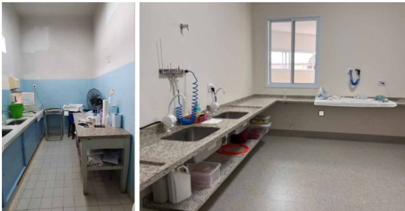
Figura 5: Sala de higienização dos materiais, antes e depois da reforma
