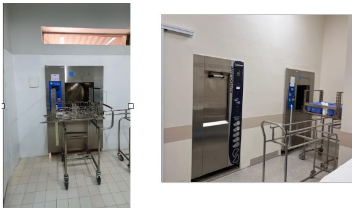
Figura 6: Área das autoclaves, antes e depois da reforma
