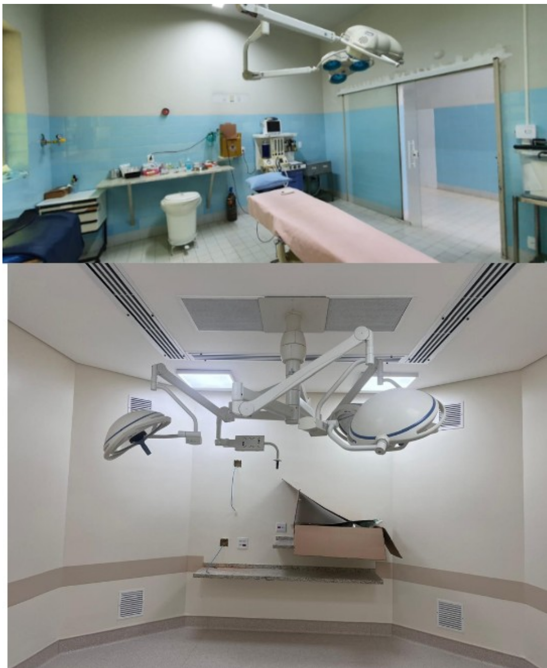
Figura 10: Sala de Cirurgia 3, antes e depois da reforma
