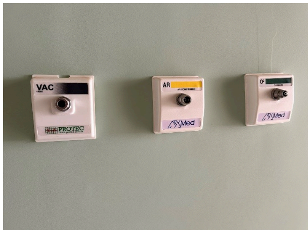
Imagens dos dispositivos da rede de gases medicinais
