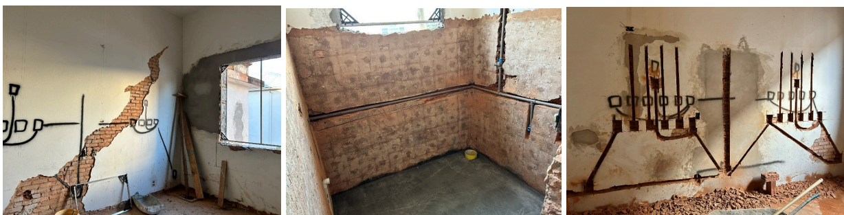
Imagens das instalações hidráulicas, esquadrias e elétrica
