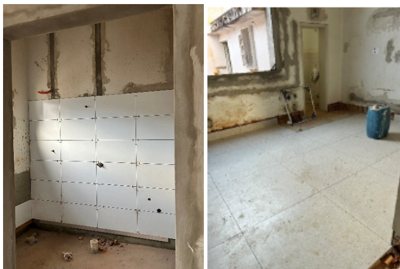
Imagens da instalação de pisos e revestimentos
