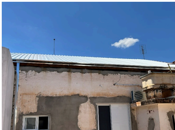
Imagens da remoção do telhado e instalação do telhado de metal
