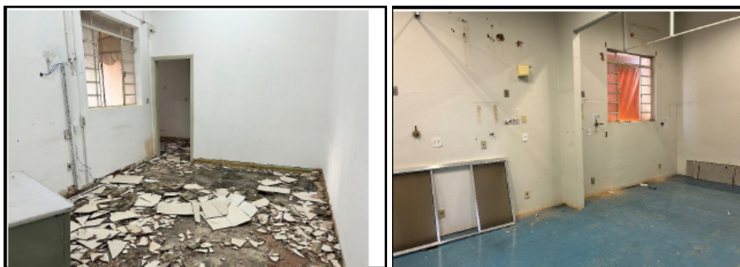
Imagens das demolições preliminares
